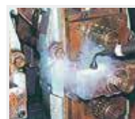
製造機器周辺の脱脂洗浄に
